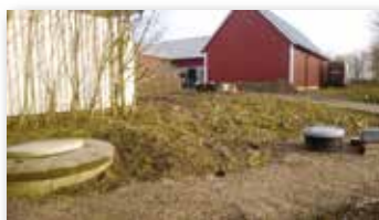
Special anläggning med pumpbrunn 2012 Ove Göransson 042-321078 Mörrarp
